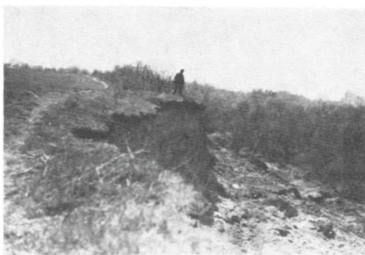
Foto 9. Aktívne zemné zrútenia v nárazovom brehu Váhu severne od Šintavy Photo 9. Active earth collapse in concave bank of Váh river north of Šintava
